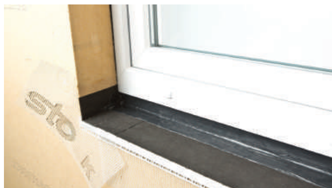
Système StoFentra Guard est ici visible avant la mise en œuvre de l'enduit et de l'appui de fenêtre.
